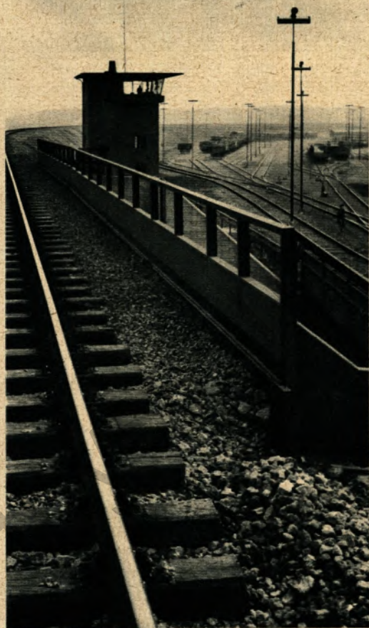
▲ Durch den Bau des neuen Siemens-Martin-Werks wurde die Verlegung der Hafenbahn notwendig; die früher das Werksgelände auf der Stockheide durchschneit
