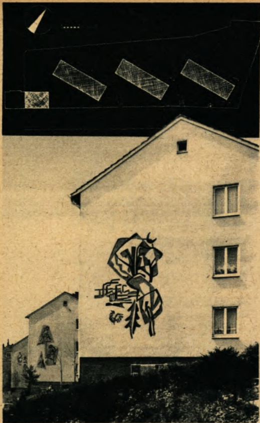
▲ Schräg zur Straße und gegeneinander versetzt stehen die drei Zwölf-Familien-Häuser in der Hohenlimburger Möllerstraße, die für die Belegschaftsangehörigen der Hoesch Walzwerke AG errichtet wurden. Die Stirnseiten sind durch Sgraffitos des Graphikers Friedrich aus Gevelsberg belebt. Unser Foto rechts zeigt, wie die Häuser wirken, wenn sie von der Straße aus gesehen werden
