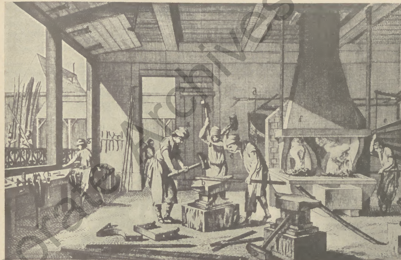
Abb. 3 Ehe Walzwerke zur Verfügung standen, mußte alles Langeisen mühselig von Hand geschmiedet werden.
