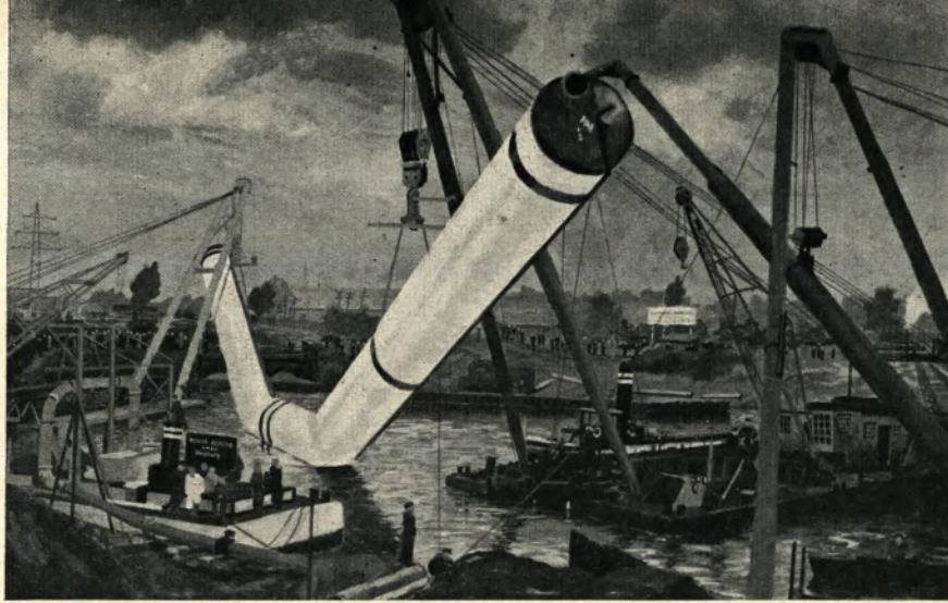
Dieses eindruckesstarke Gemälde von der Verlegung eines mit unseren Rohren von der Firma Heinrich Hirdes GmbH gefertigten Dükers schuf unser Belegschaftsmitglied H. Bombitzky
