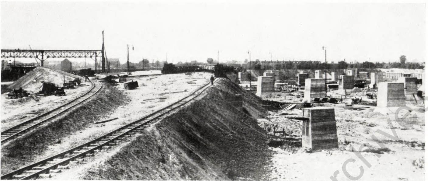
Fundamentstützen für das Blechwalzwerk II unserer Hütte wurden 1910 gegossen, das Gelände — alte Bruchlandschaft — danach angeschüttet.
