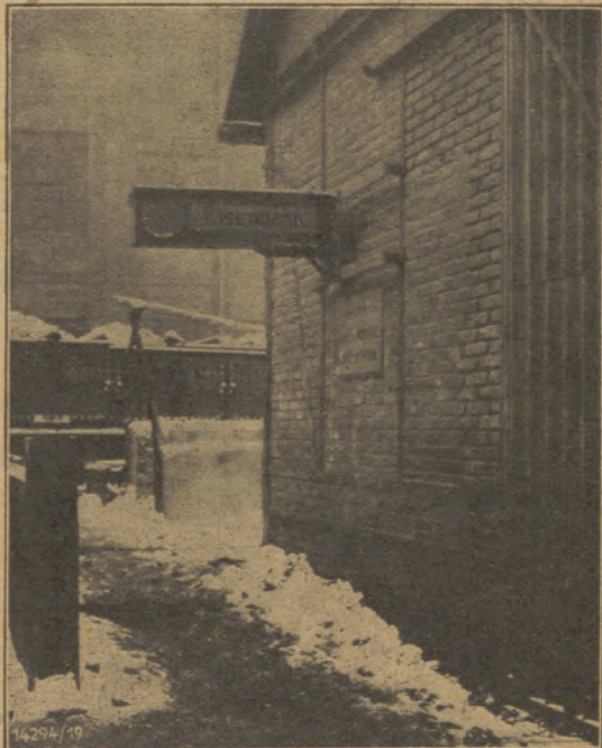
Signalarm bei Gleisübergängen
