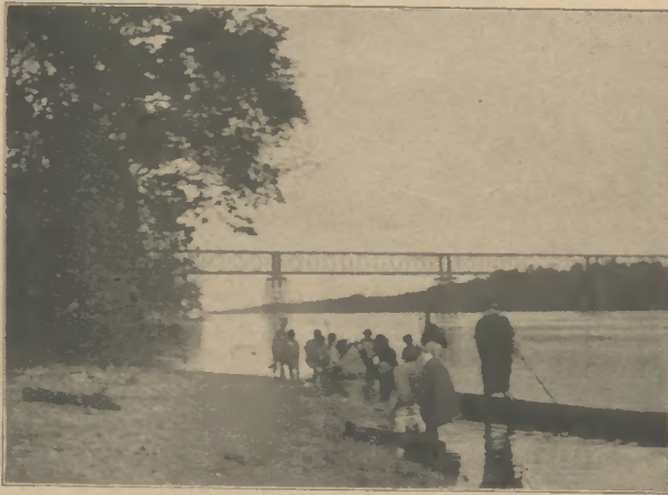
Eisenbahnbrücke vor Bridaville, am Ufer des Flusses ein Fährmann in einem „Einbaum“
