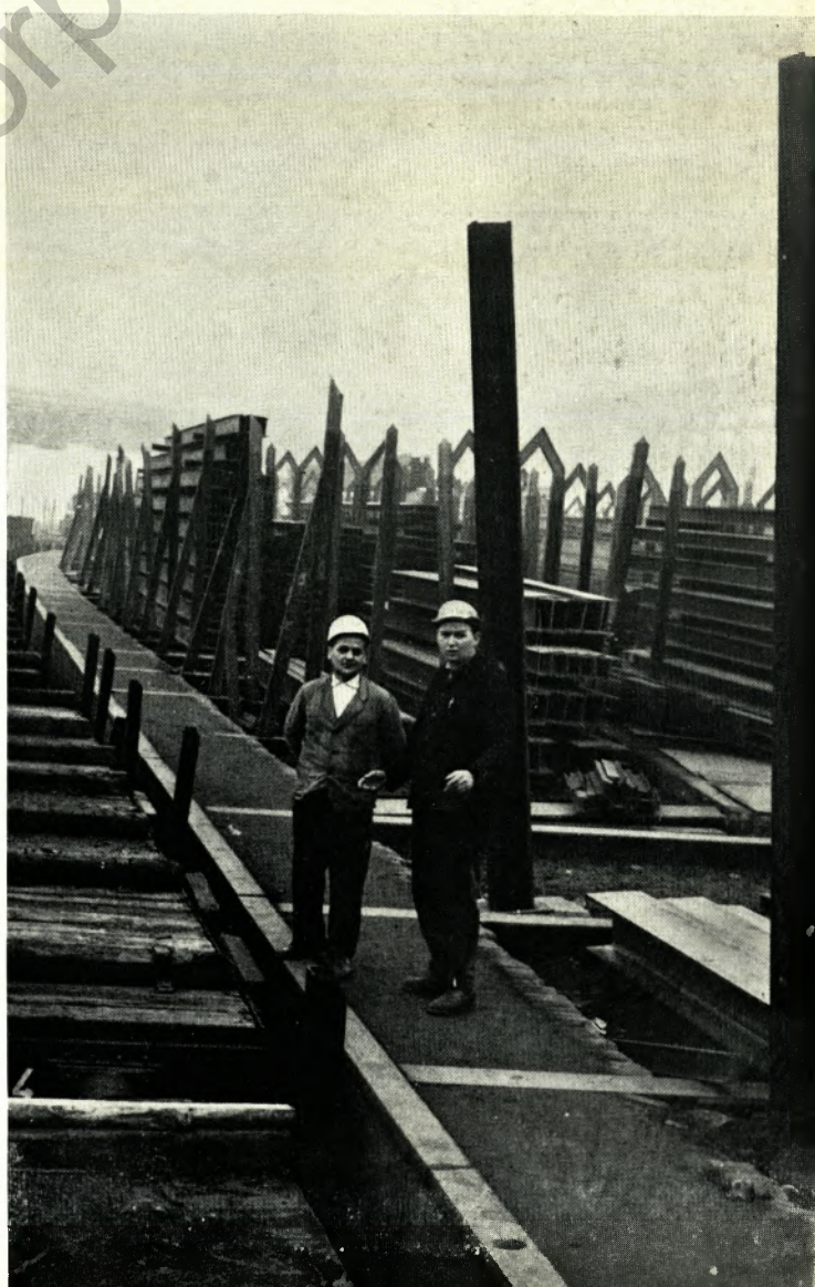
Rangiermeister Döppers bespricht mit dem Verlademeister die Leertwagenbereitstellung am Trägerlager 1 der ATH.
