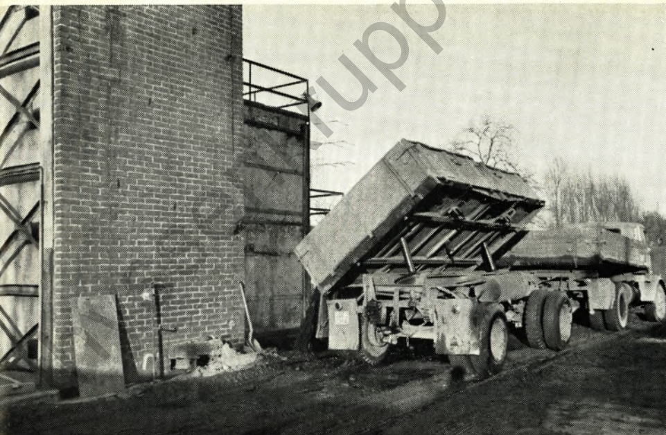
Hier werden vom Lastwagen aus Waschberge in den Schacht gekippt.
