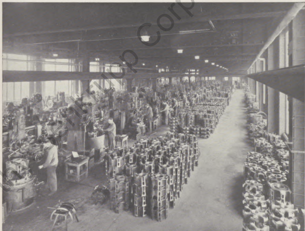
Maschinensaal 2 im Bokerbau, Werk Stadelhausen
