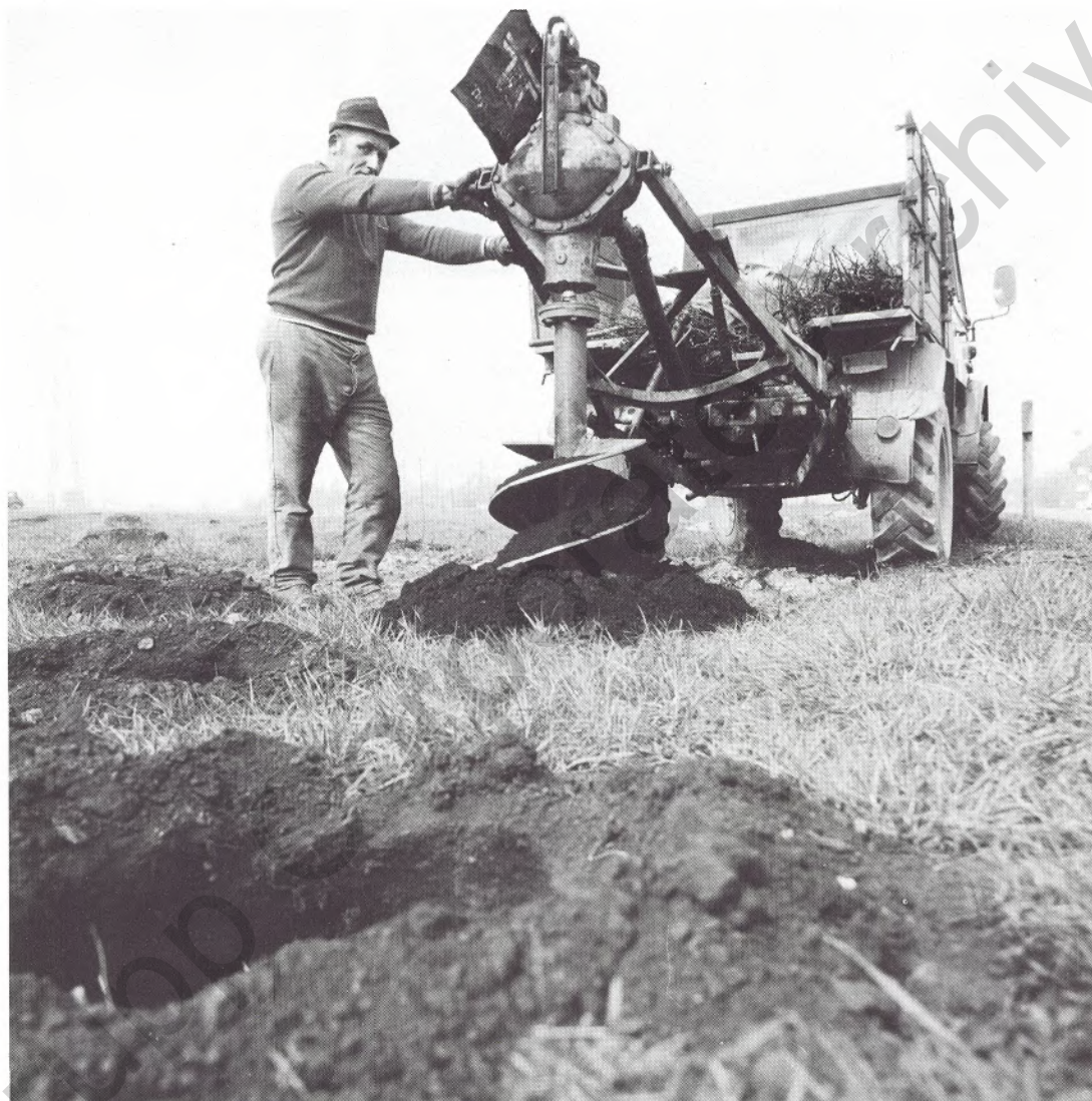
Mit diesem Spezial-Bohrgerät wurden die Pflanzlöcher für die Aufforstung im Bereich „Kleine Emscher“ hergestellt.
