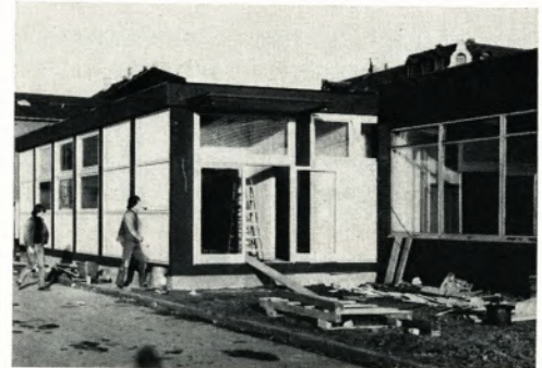
Der Aufenthaltsraum für die kaufmännischen und technischen Auszubildenden des TN-Werkes Duisburg (siehe Meldung in DDD 4/1972) befindet sich bereits im Bau. Das Gebäude wird in Fertigbauweise hinter der Lehrwerkstatt erstellt.
