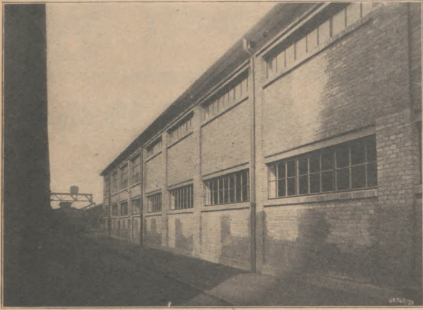
Außenansicht des neuen Waschkauengebäudes; man beachte die schönen, breiten Lichtbänder, die nur durch die tragenden Pfeiler unterbrochen werden
