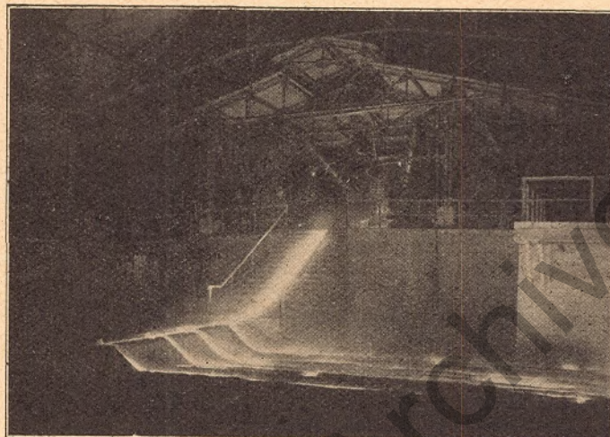
Arbeiten am Stichloch nach dem Anblasen Abstich. Das Roheisen läuft in die Masselformen (Sand)
