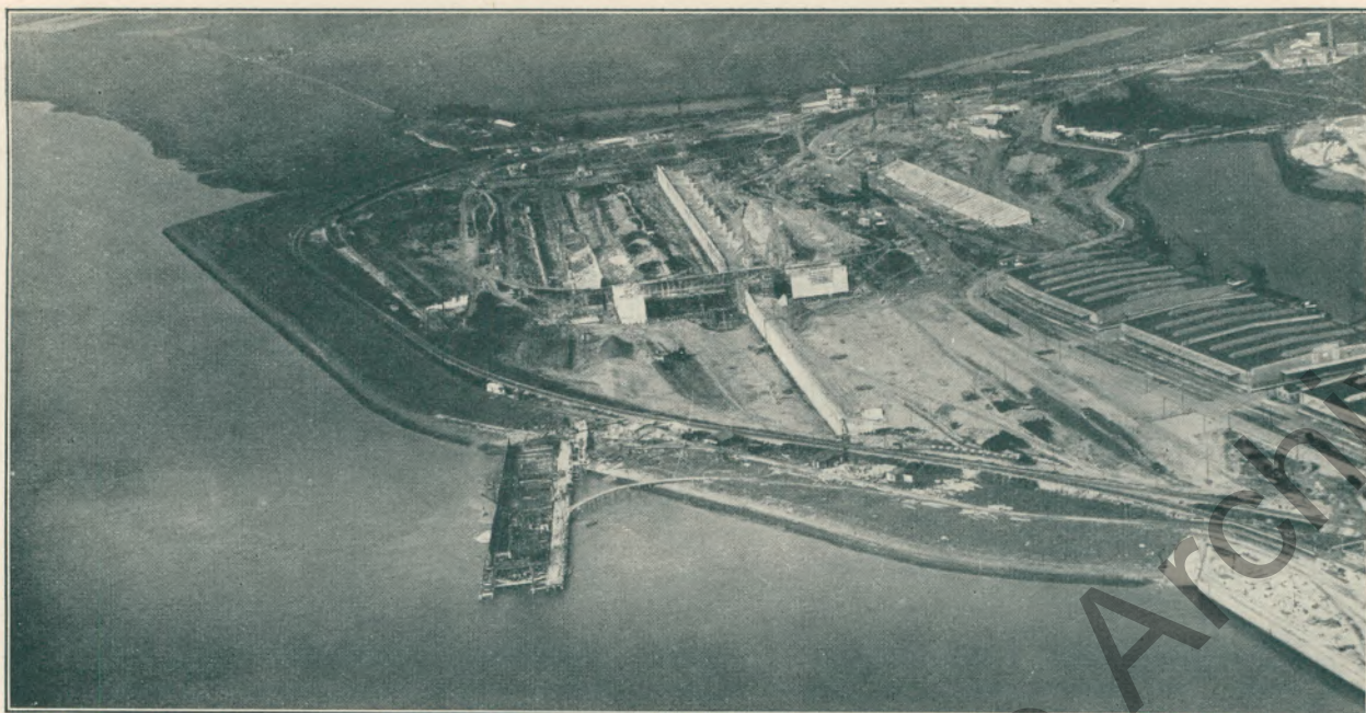
Die größte deutsche Seeschleuse im Bau.
