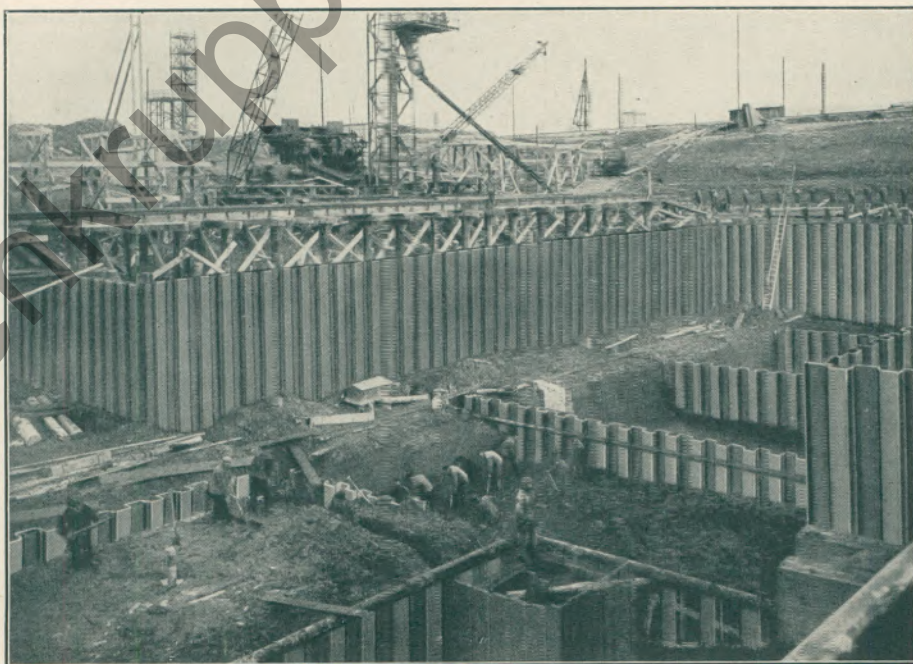
Blick in die von Stahlspundwänden eingefassten Baugruben.
