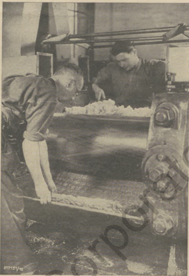
Aufarbeitung synthetischen Kautschuks (Buna)
