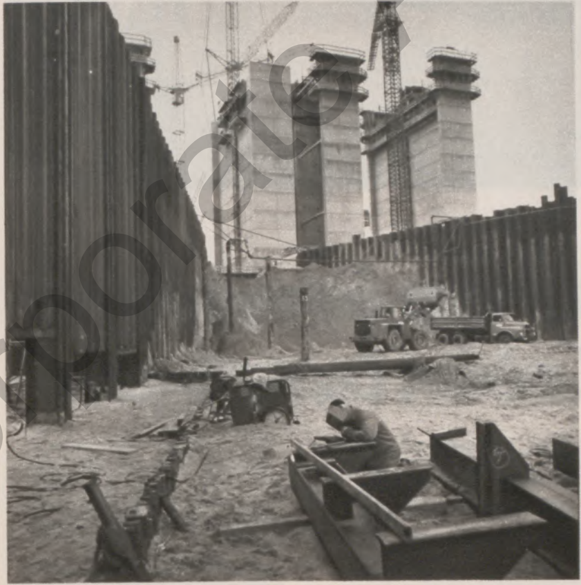
▼ Hoesch-Splundwand säumt die Einfahrten und Vorhäfen des Schiffshebewerks
