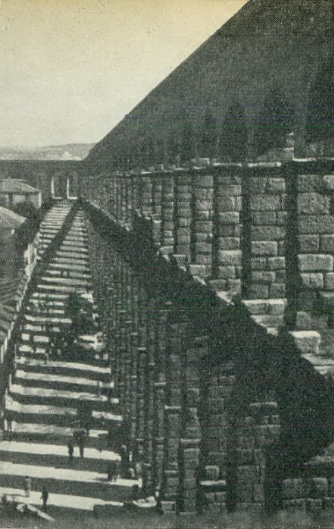
Die römische Wasserleitung von Segovia. Die Steine werden ohne Mörtel zusammengehalten
