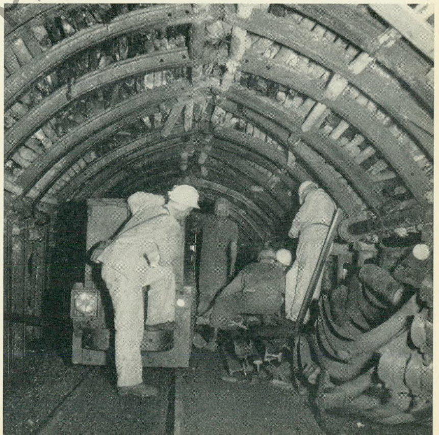
Eine vier Tonnen schwere Akku-Lok muß mit primitiven Mitteln aufgegleist werden
