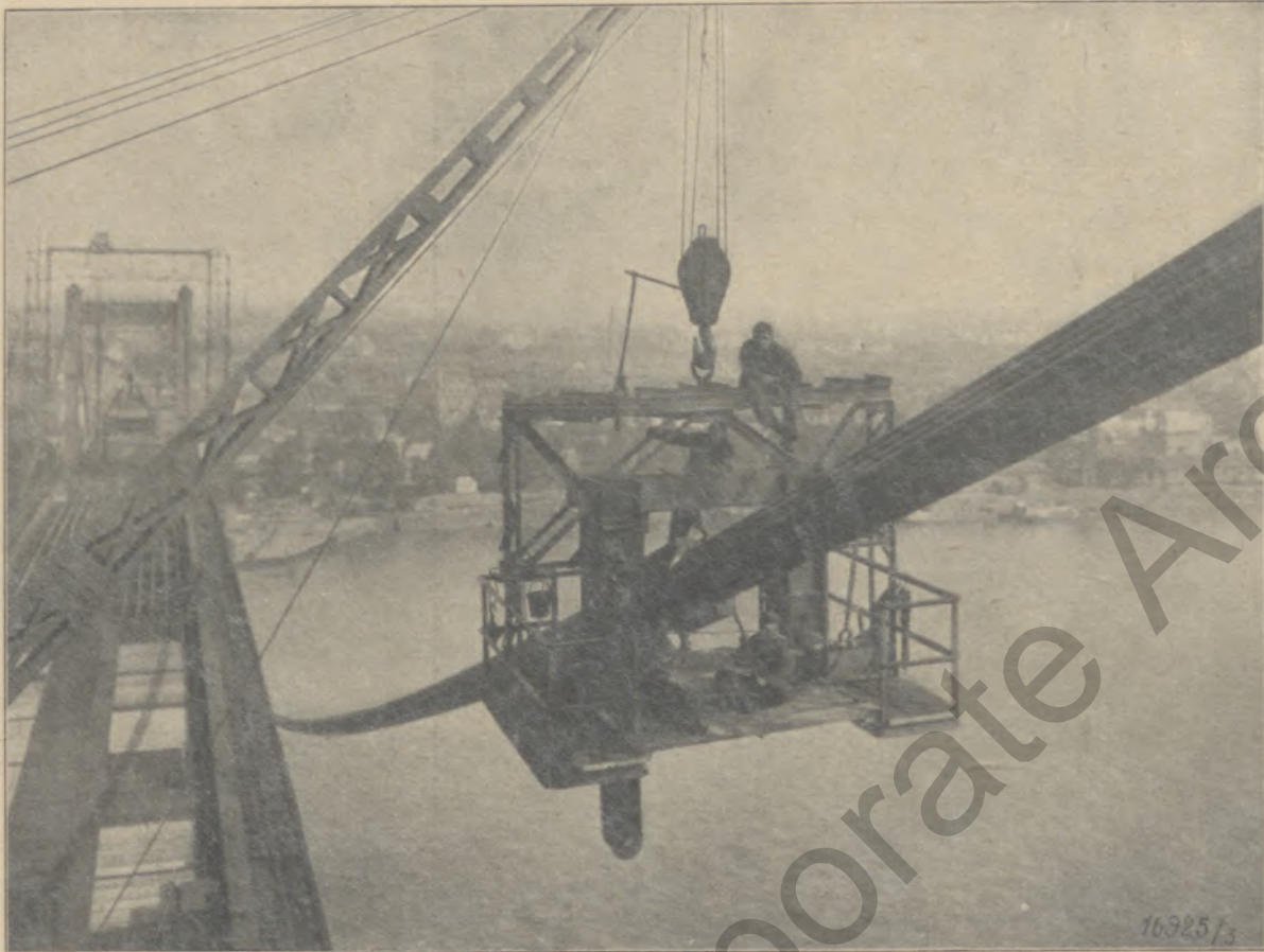
In luftiger Höhe bei der Brückenmontage
