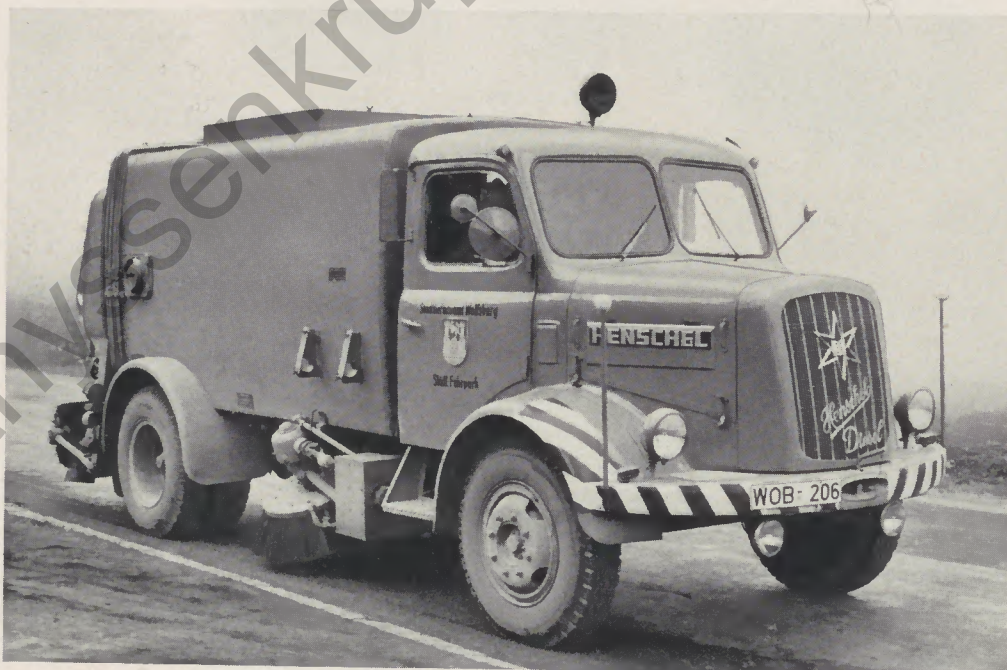
Eine selbstaufnehmende Kehrmaschine auf Henschel-Fahrgestell Typ HS 100 K, Motorleistung 105 PS, für den Städtischen Fuhrpark des Stadt-Tiefbauamtes Wolfsburg.
