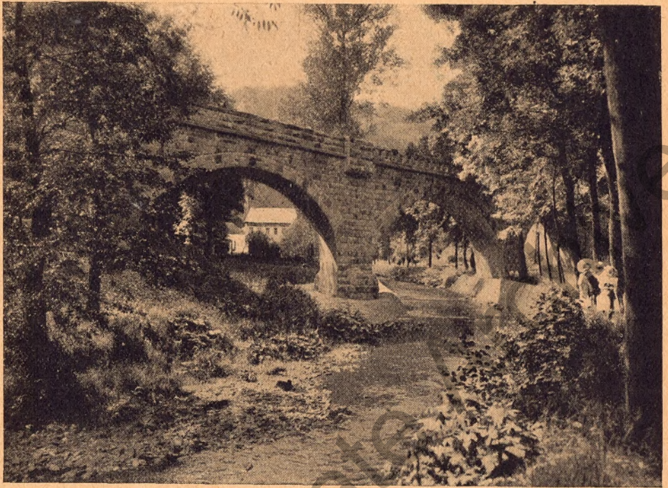
Bahnviadukt am Ahufels im Hönnetal (Westfalen)
