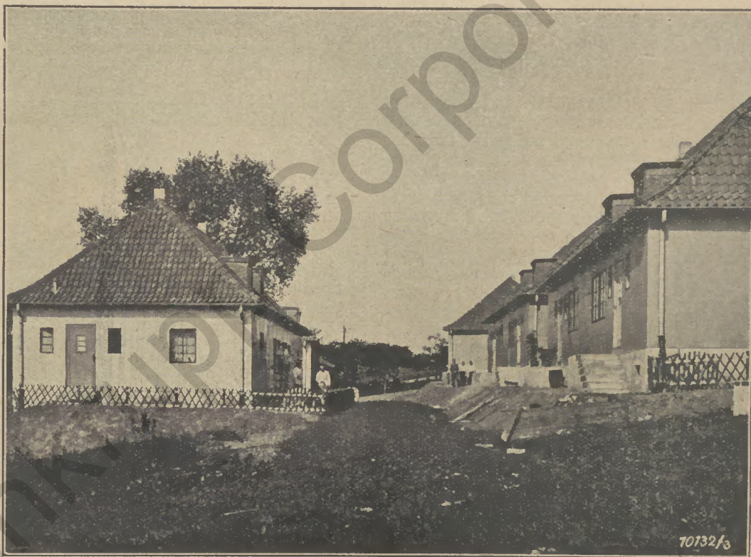
Unsere neue Stahlhausiedlung an der Marxstraße
