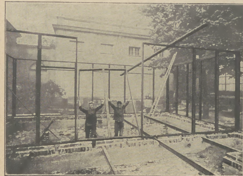
Aufrichten der Leichtprofilrahmen am Stahlrahmenhaus
