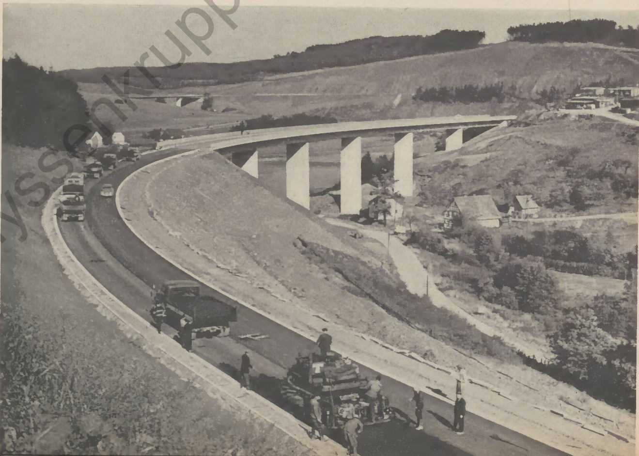
Biggetalsperre: Talbrücke Kessenhammer. Herstellung der Fahrbahndecke
