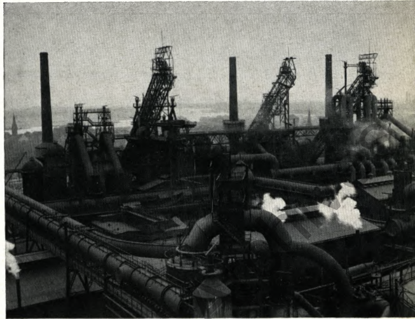
Von den eigentlichen Hochofen ist kaum etwas zu erkennen. Sie werden überragt von den Schrägaufzügen. Die Kamine gehören zu den Winderhitzern
