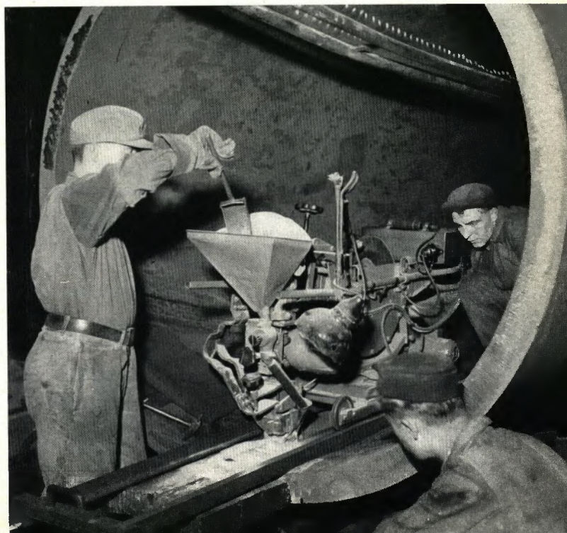
Ellira-Schweißaggregat beim Schweißen der Innennaht eines Behälters
