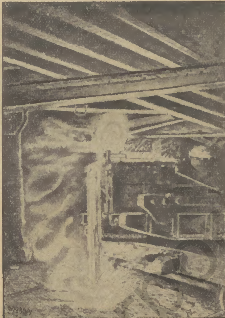
Ausgießen des Stahles in die Gießpfanne Partie aus dem Thomasstahlwerk des Hoerder Vereins Bleiszeichnung von Hugo Siebent, Blechwalzwerk, Hoerder Verein
