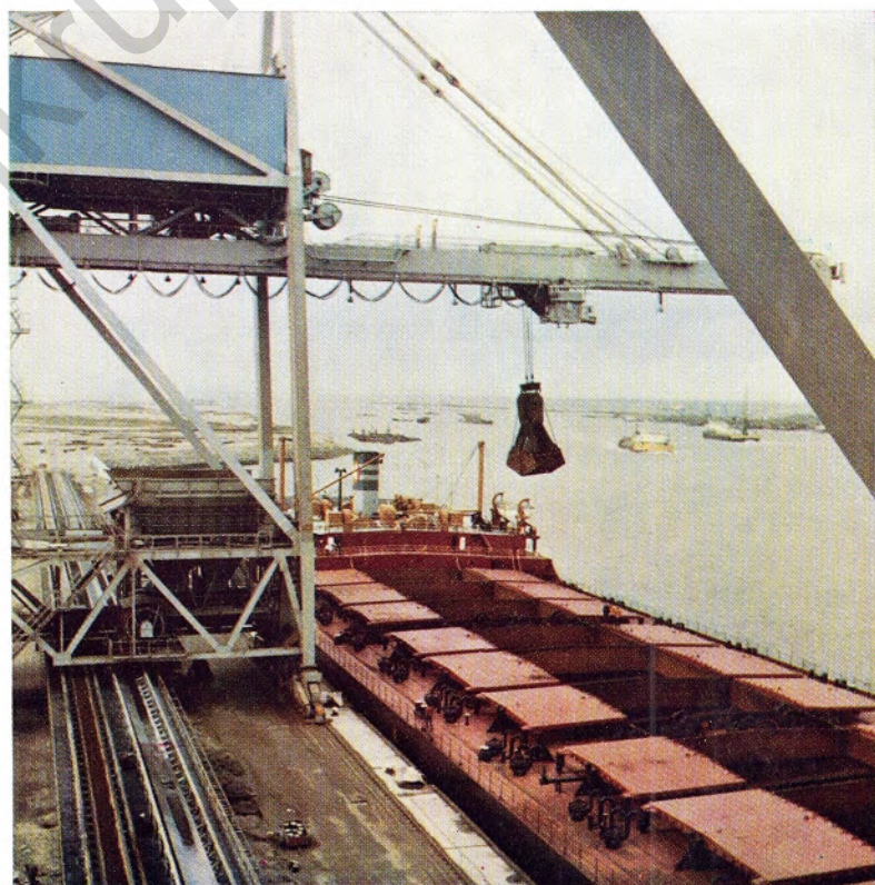
DIE BILDER ZEIGEN die beiden See-Schiffsentlader am 600 Meter langen Seekai der Erz-Umschlaganlage Europoort
