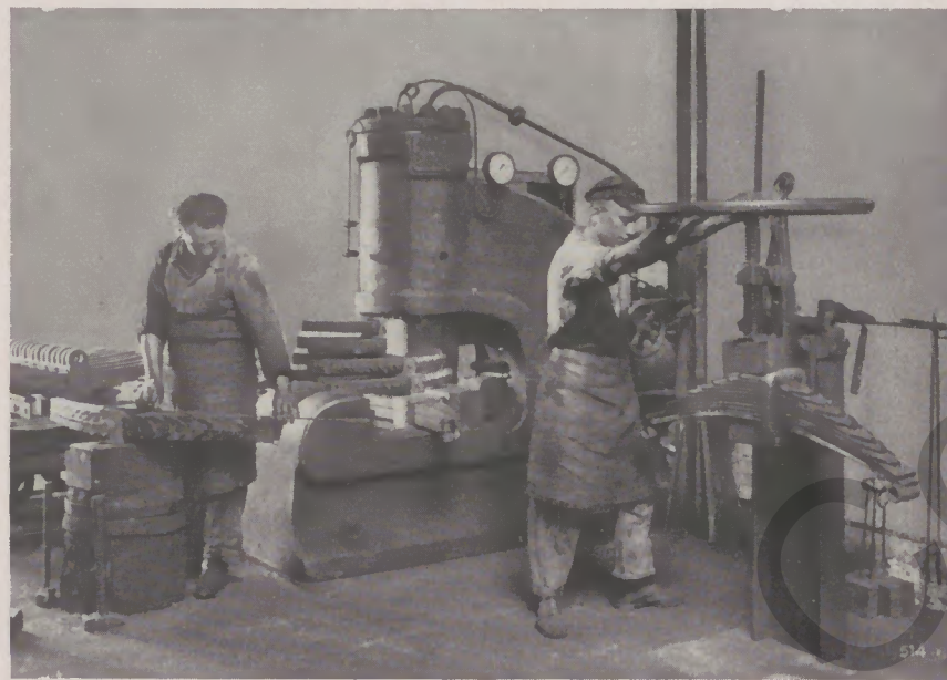
Abb. 12: Aufsprüngen des Federbundes auf eine schwere Eisenbahnfeder
