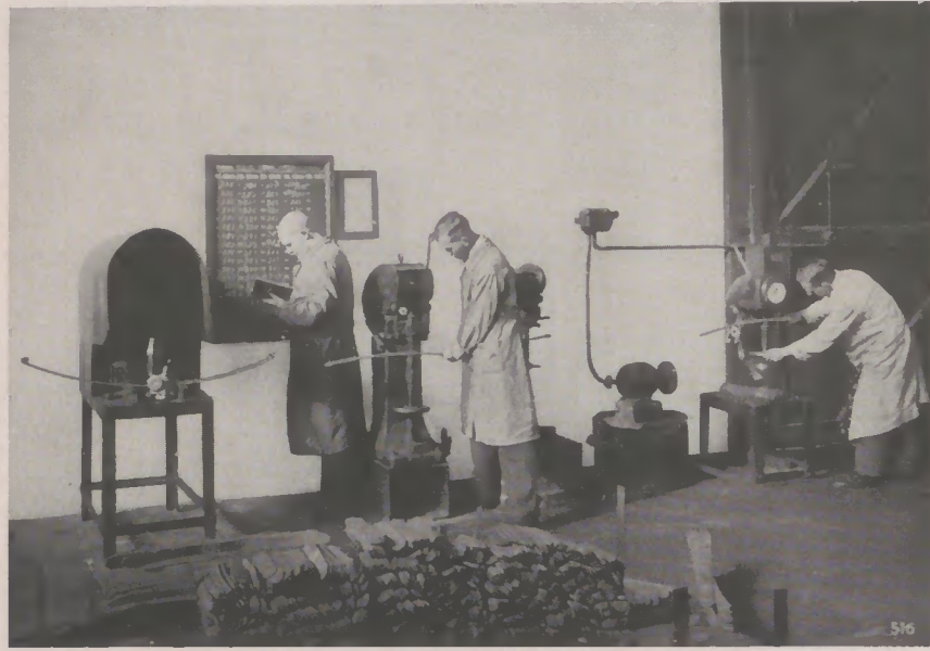
Abb. 10: Brinellprobe einzelner Blöcke
