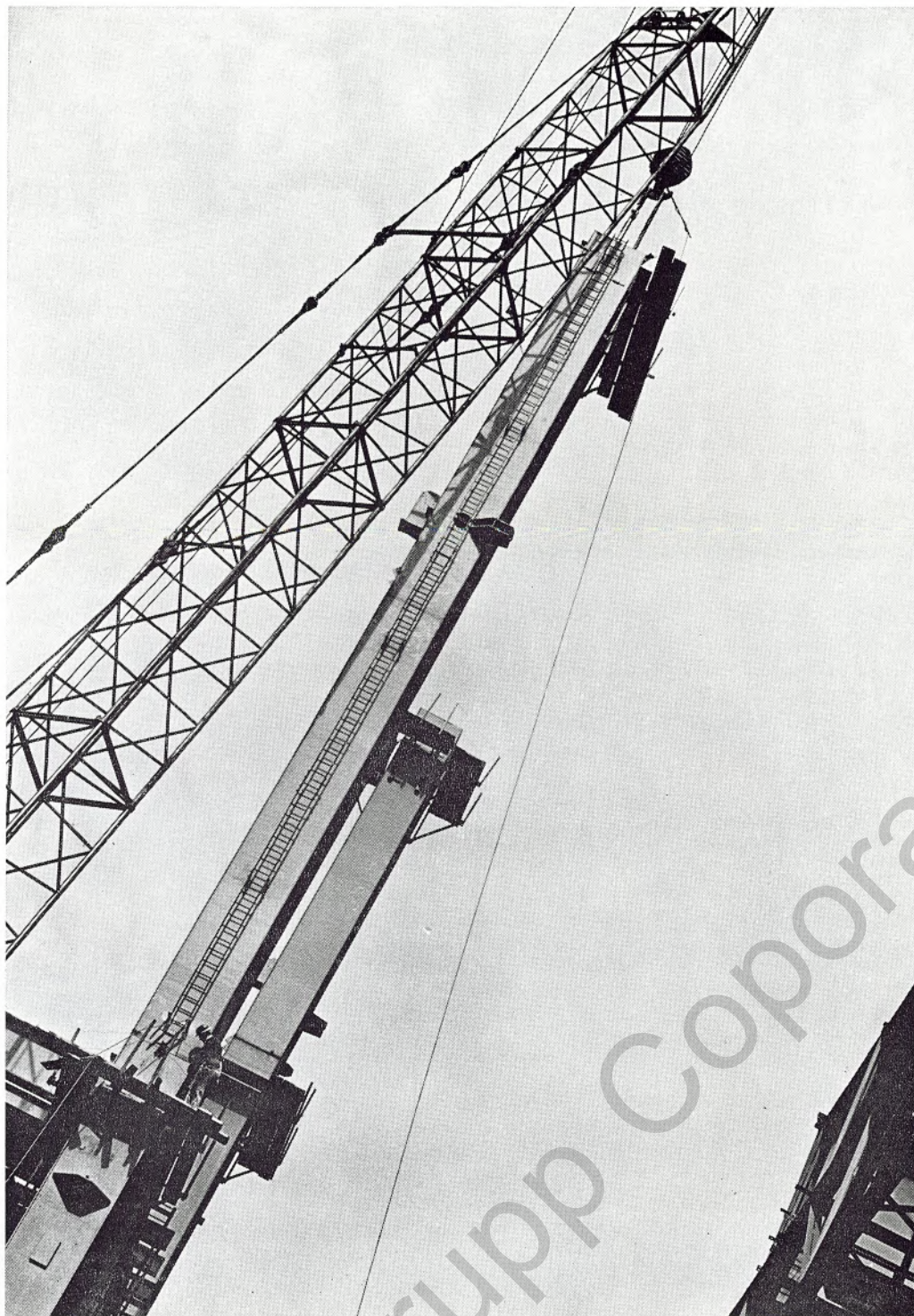
DER BAU DES NEUEN OXYGEN-STAHLWERKES der ATH in Bruckhausen schreitet rüstig fort. Ende Juli wurde die erste Stütze gesetzt — seither sind die Montagearbeiten bereits weit fortgeschritten (siehe den Bildbericht auf Seite 7)
