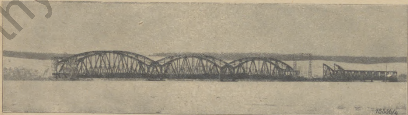
Dem Ende zu: Der Zustand des Brückenrestes am 7. März 1929
