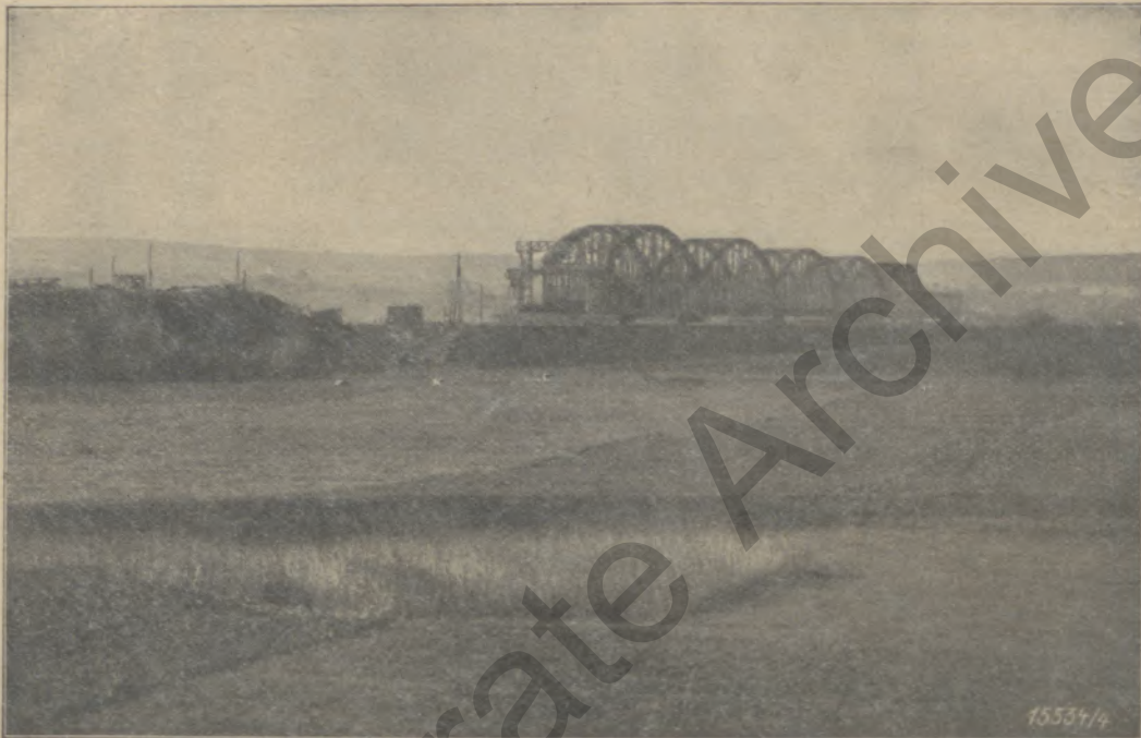
Der Stand der Abbrucharbeiten am 27. Oktober 1928
