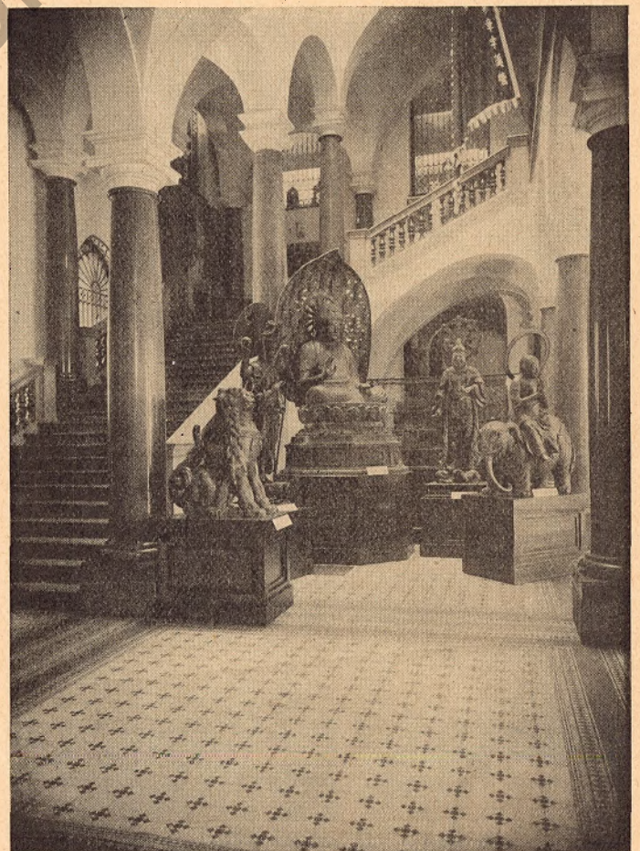
Abb. 3. Blick ins Treppenhaus
