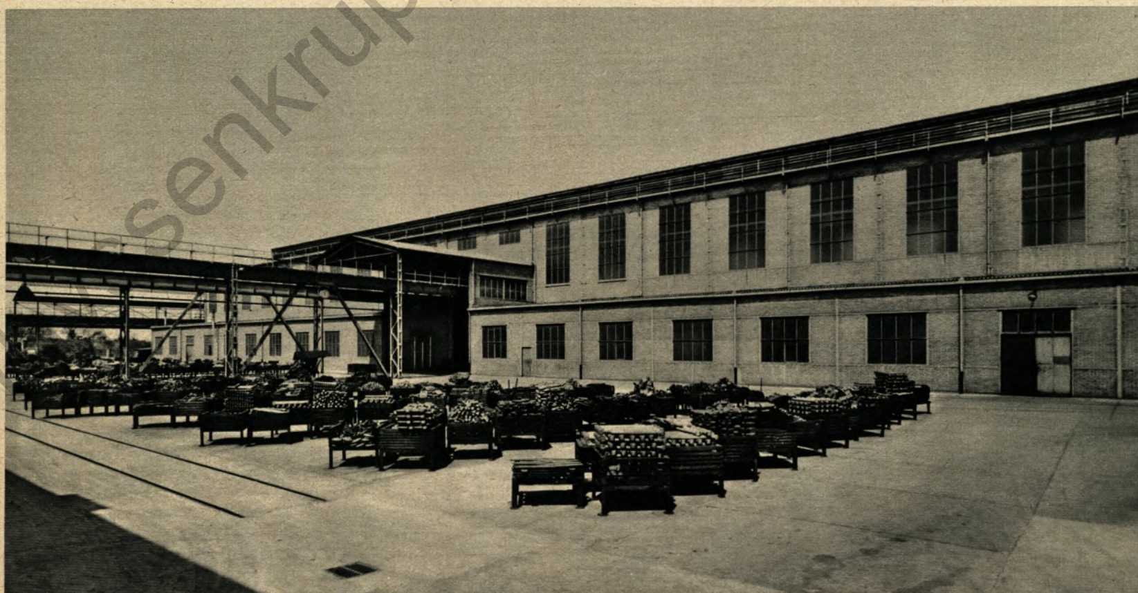
Die neue Schmiedehalle der Schwinn AG in Homburg/Saar. Auf dem Werkshof liegen halbfertige Gesenkschmiede-Erzeugnisse in Transportkästen zur Verladung bereit
