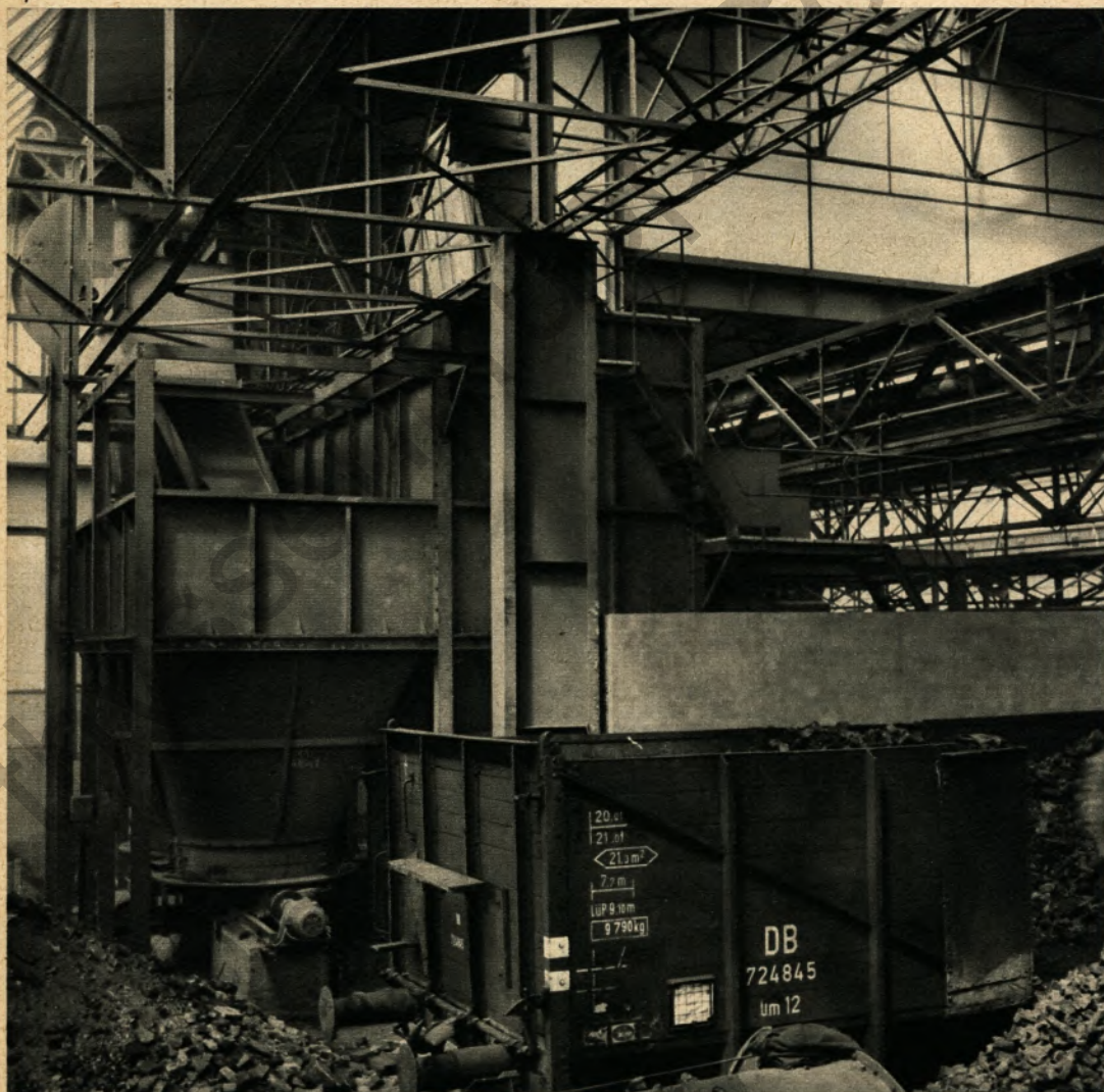
Das ist der Erweiterungsbau der Gießerei. Die Sandaufbereitungsanlage ist schon deutlich zu erkennen
