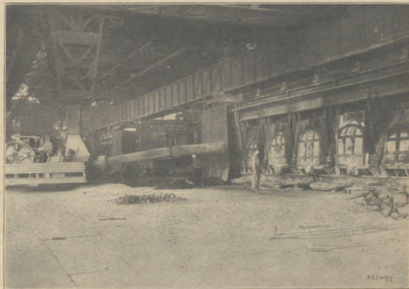
Martinwerk II / Chargierbühne
