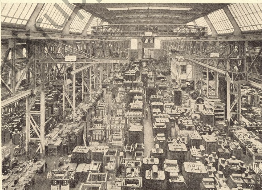
Gesamtansicht der Montagehalle für große Transformatoren im Transformatoren-Werk der Siemens-Schuckert-Werke in Nürnberg
