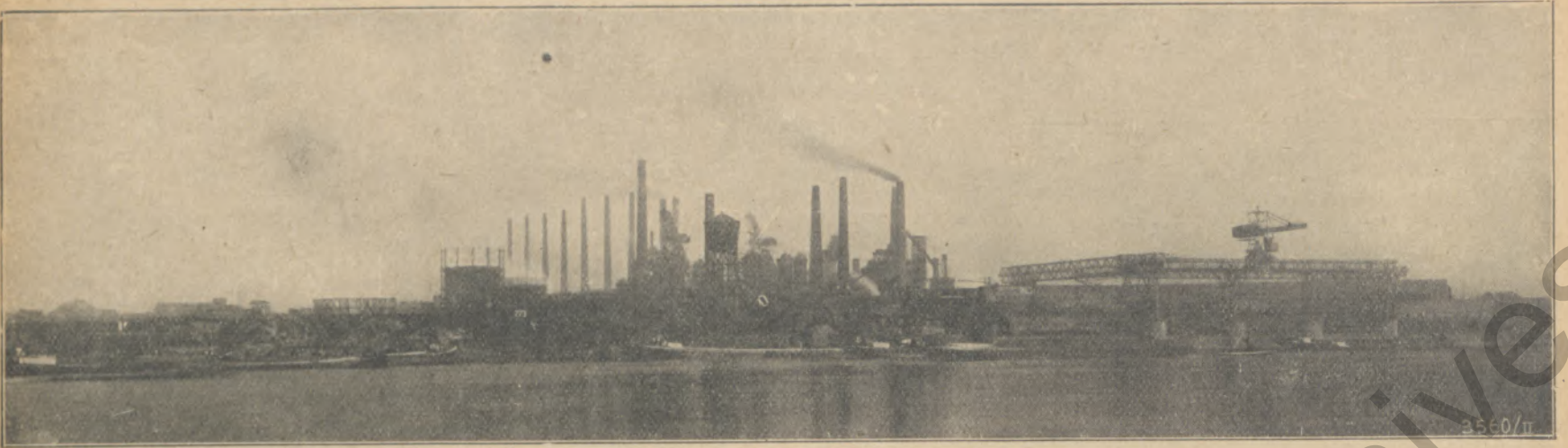
Blick auf die Niederrheinische Hütte der Vereinigte Stahlwerke A.-G. bei Duisburg
