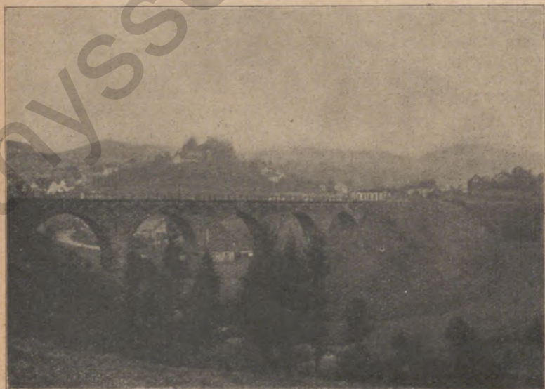
Eisenbahnviadukt bei Daun (Eifel) Aufnahme: Otto Schäfer, Werk Hoerde
