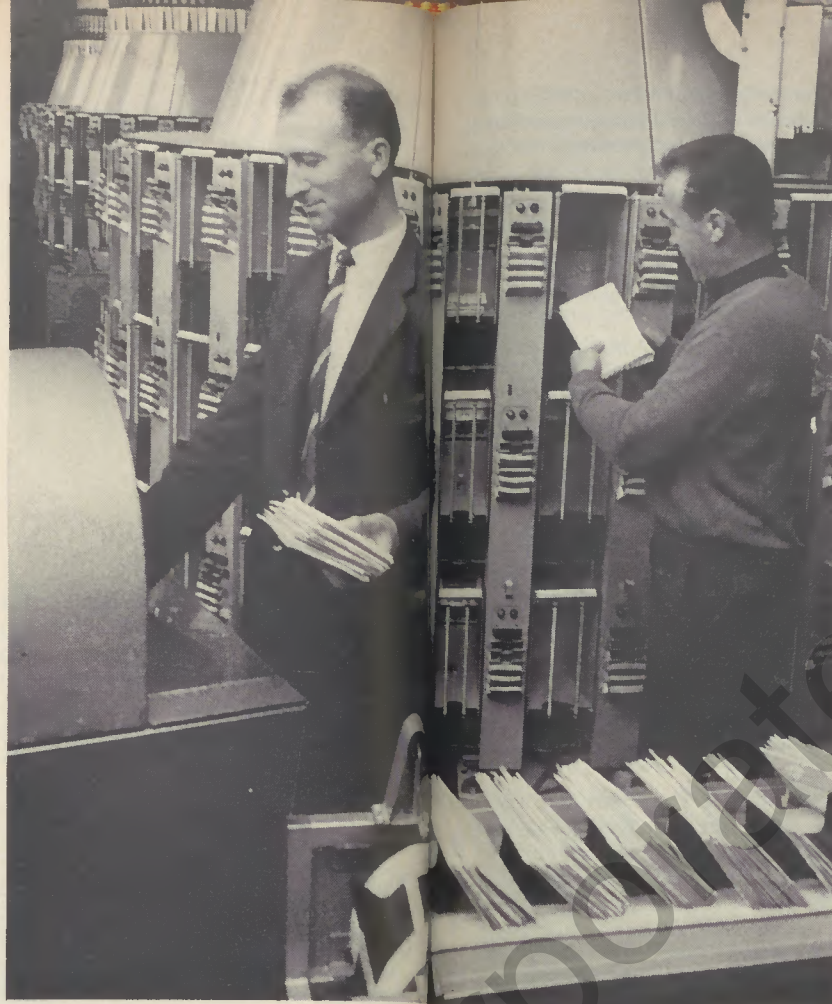
Vollautomatische, elektronisch gesteuerte Sortieranlage
