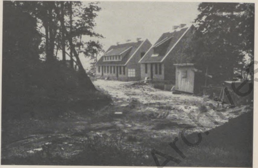
Bauvorhaben Remscheid, Bürgerstraße
