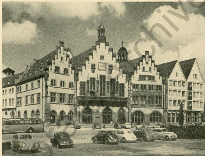
Frankfurt, Römer nach dem Wiederaufbau
