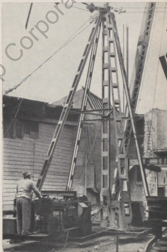
Bild 1 links: Abbrucharbeiten (Teilansicht) als Vorleistung für den nachfolgenden Aufbau der neuen Sandaufbereitung. Sicht gegen das bisherige Sandlager und die alte Sandaufbereitung.
