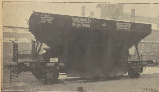
Bild 10: Zweiaxiger Selbstentlader, nach beiden Seiten entleerend
