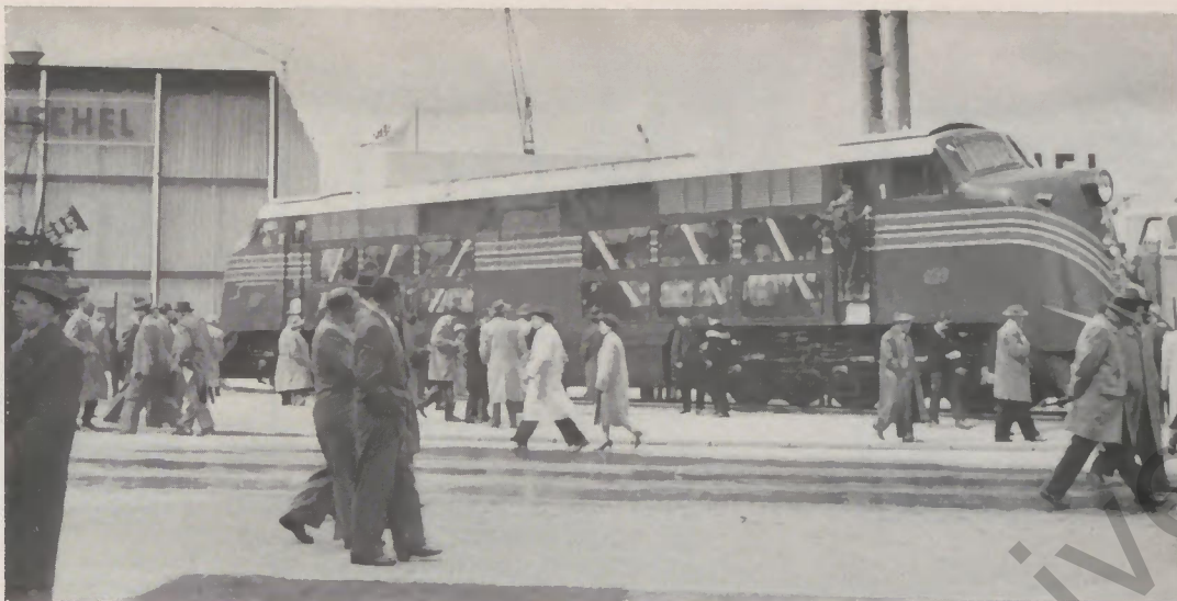
Einer der Hauptanziehungspunkte der Deutschen Industriemesse war die von uns gezeigte 1900 PS starke Diesel-elektrische GM-Lokomotive für die Bahnen der Ägyptischen Republik. Um den Fachleuten und den vielen Besuchern einen Blick in das Innere der Lokomotive zu ermöglichen, wurde die eine Seite anstelle der Blechverkleidung mit Plexiglasfenster versehen.
