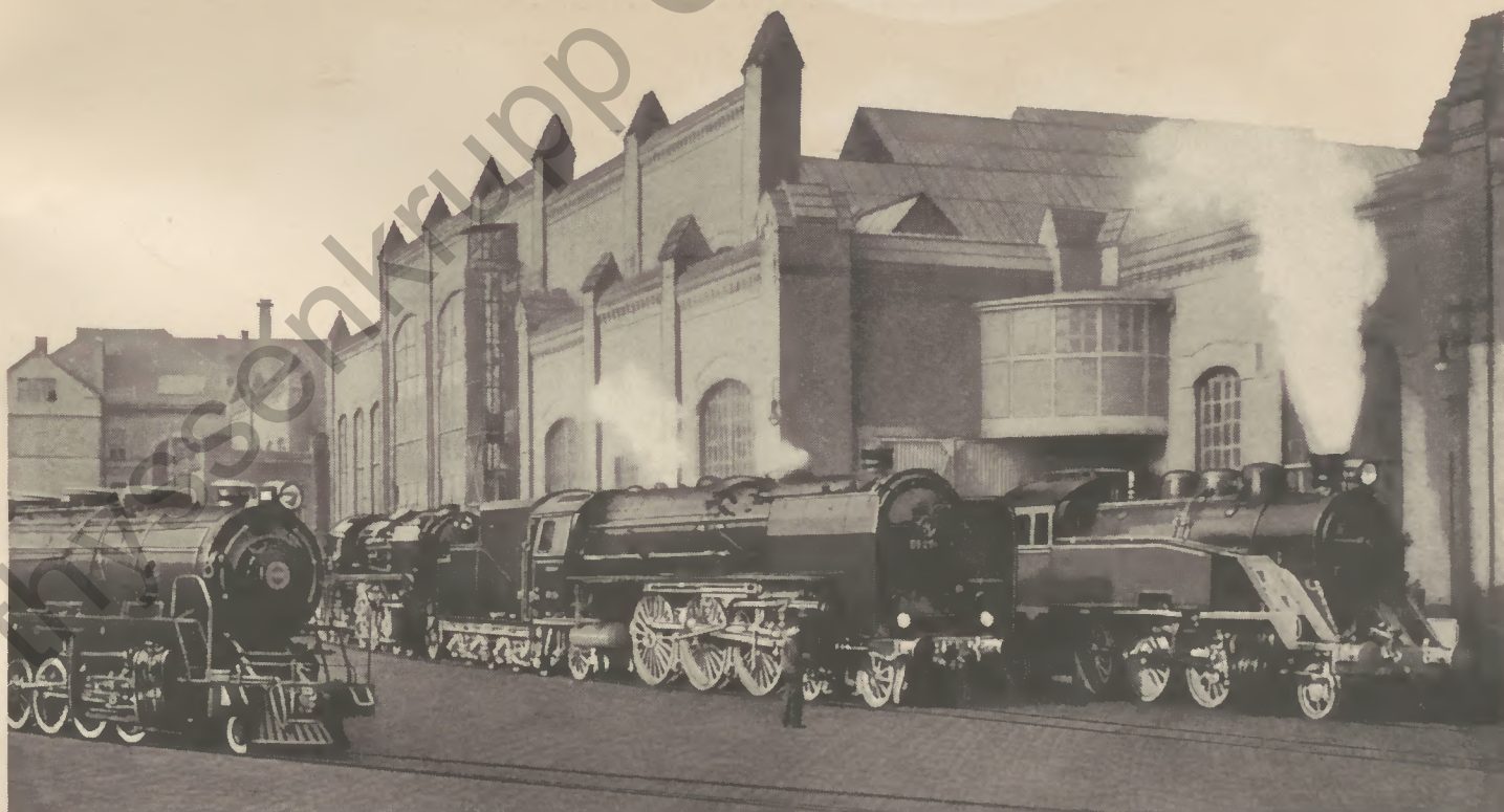
Vier Henschel-Lokomotiven für vier Länder. Von links: Südafrika 15F, Türkei 1D1, Deutsche Reichsbahn Reihe 01, Lettland 1C1
