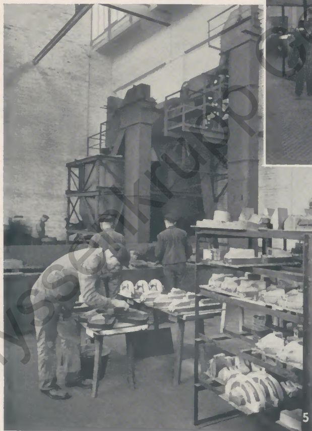
Bild 5: Der hintere Teil des Bildes zeigt die Sandaufbereitung der Leichtmetallgießerei
