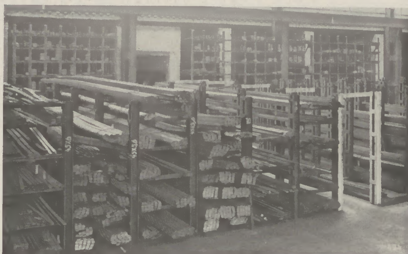
Abb. 4: Unser Stahlager. Die einzelnen Stahlorten sind durch Farben übersichtlich gekennzeichnet
