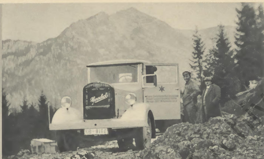
An der höchstgelegenen Baustelle der Reichs- autobahn München— Landesgrenze bei Bad Reichenhall
