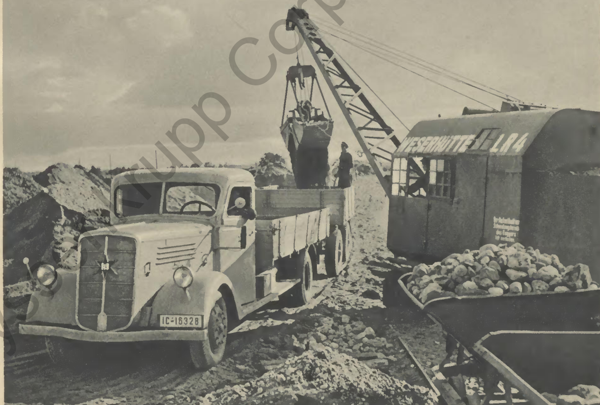
Bei Erdarbeiten in Ostpreußen (Henschel 3 1/2—4 Tonner mit Anhänger)
