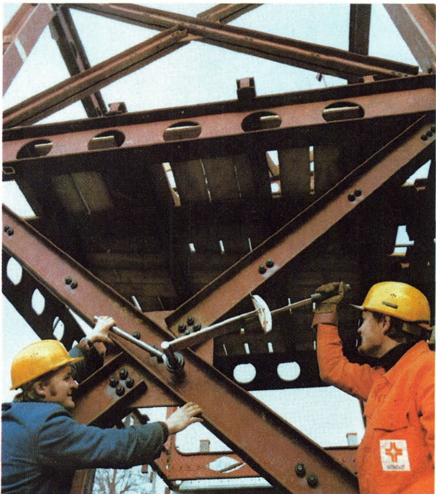
Schraubendreher und Schraubenschlüssel ersetzen bei den Mitarbeitern der Metastadt-Baugesellschaft Kelle und Hammer. Links: Teile des Rahmens
