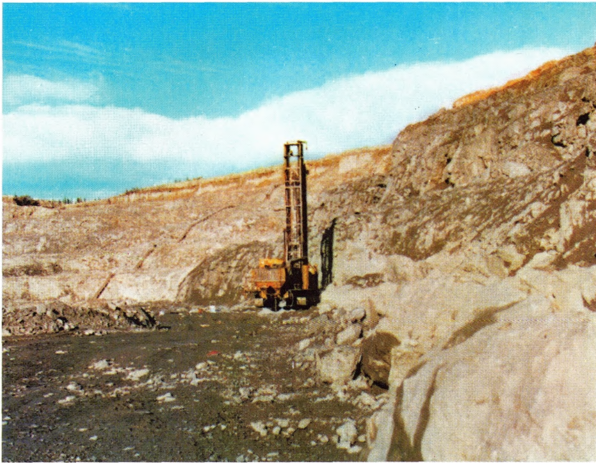
Mächtige Bohrmaschinen, wie überall im Erztagebau, schaffen die für die Sprengung erforderlichen Sprenglöcher
