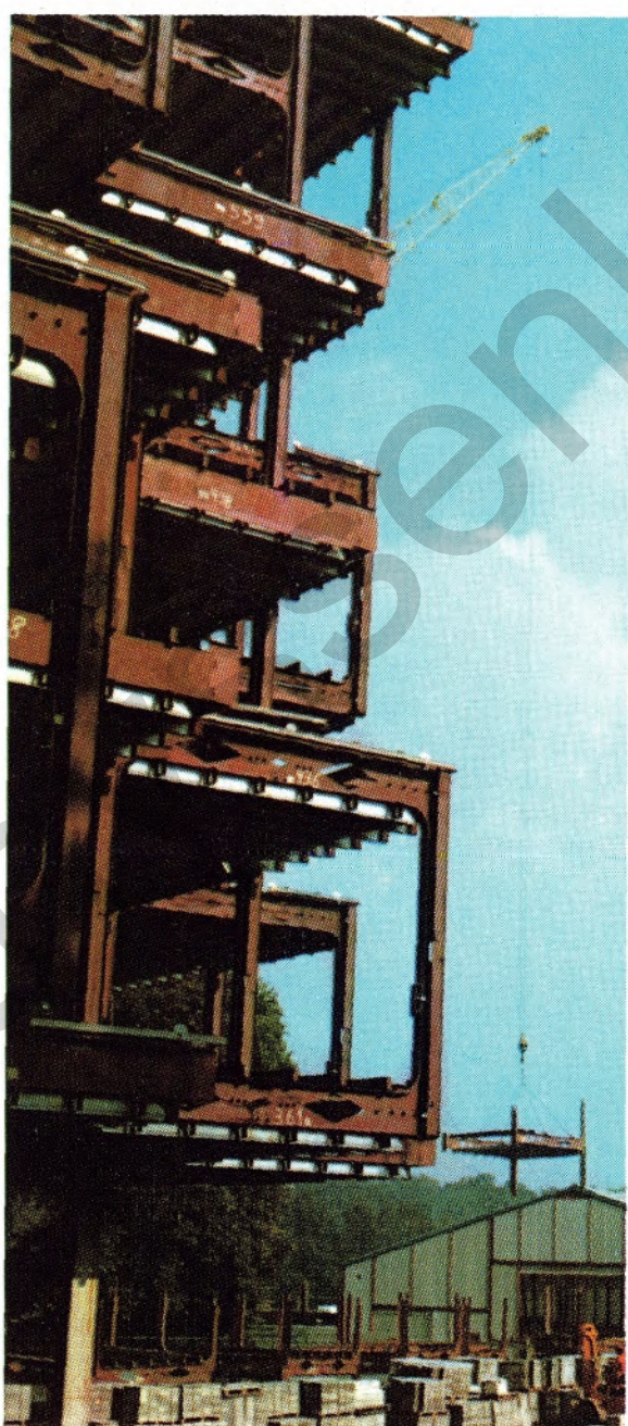
Metastadt in Wulfen — links fertige Raumzellen, rechts das die Zellen tragende Stahlgerüst
