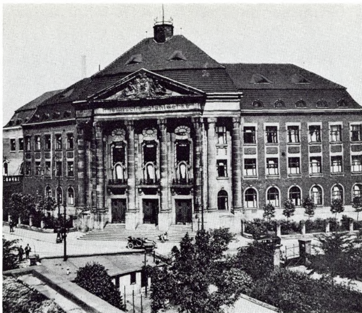
Das alte Verwaltungsgebäude der früheren Rheinischen Stahlwerke an der Ecke Mühlenfelder Straße und Stahlstraße. Dies ist eines der ältesten noch auffindbaren Fotos. Vor der großen Freitreppe ein prächtiger „Oldtimer“. Hier sind jetzt unter anderem die Abteilungen Arbeitssicherheit, Werkfeuerwehr, Werkschutz des Werkes Ruhrort untergebracht
