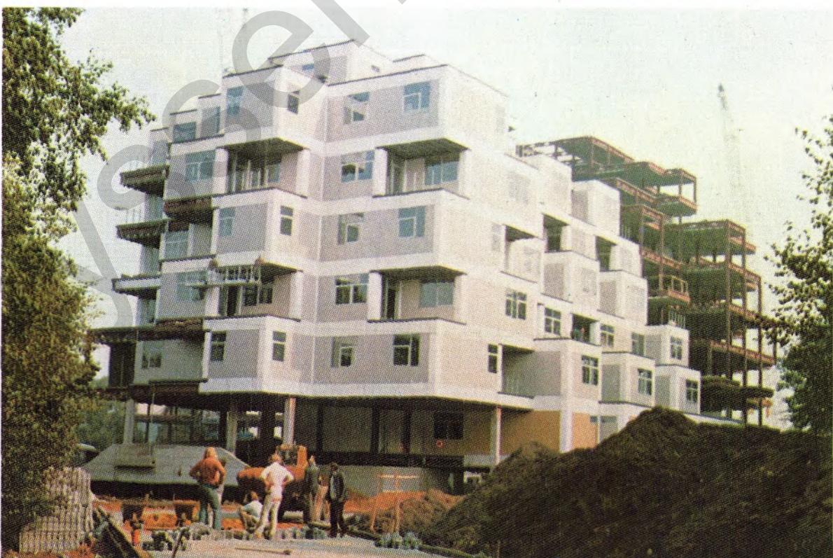
Oben: Eine Ansicht des Metastadt-Gebäudes in Wulfen, die das „Vorher-Nachher“ (Gerüst und fertige Fassade) zeigt. Der Zustand auf dem rechten Bild entspricht annähernd dem Zustand eines konventionellen Gebäudes beim Richtfest. Dieses Haus jedoch ist wenige Wochen später fertig
