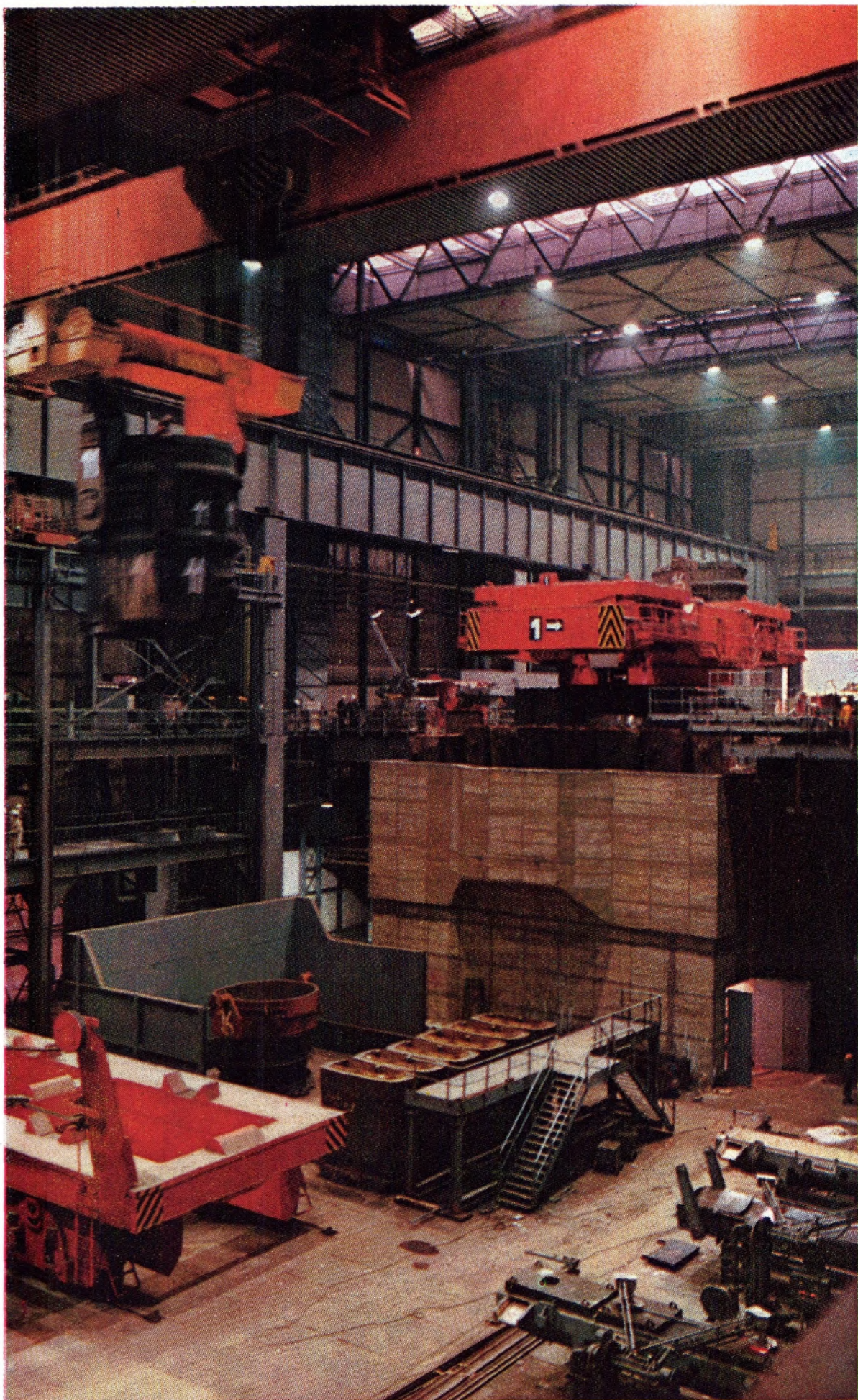
Der Gießkran setzt die Pfanne in den Drehturm ein, der rechts im Bild zu sehen ist
