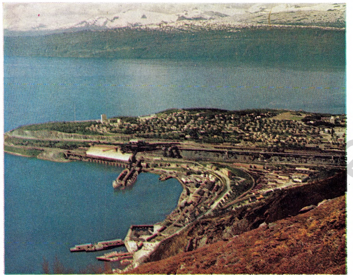
Im Hafen Narvik wird fast die gesamte Produktion des Erzes aus Kiruna verschifft. Die Umschlagskapazität wird durch eine neue Kaianlage erweitert
