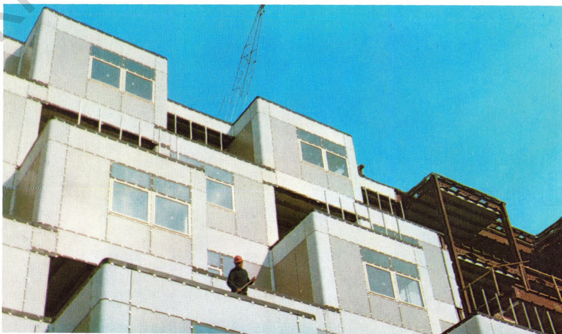
Metastadt in Wulfen — links fertige Raumzellen, rechts das die Zellen tragende Stahlgerüst
