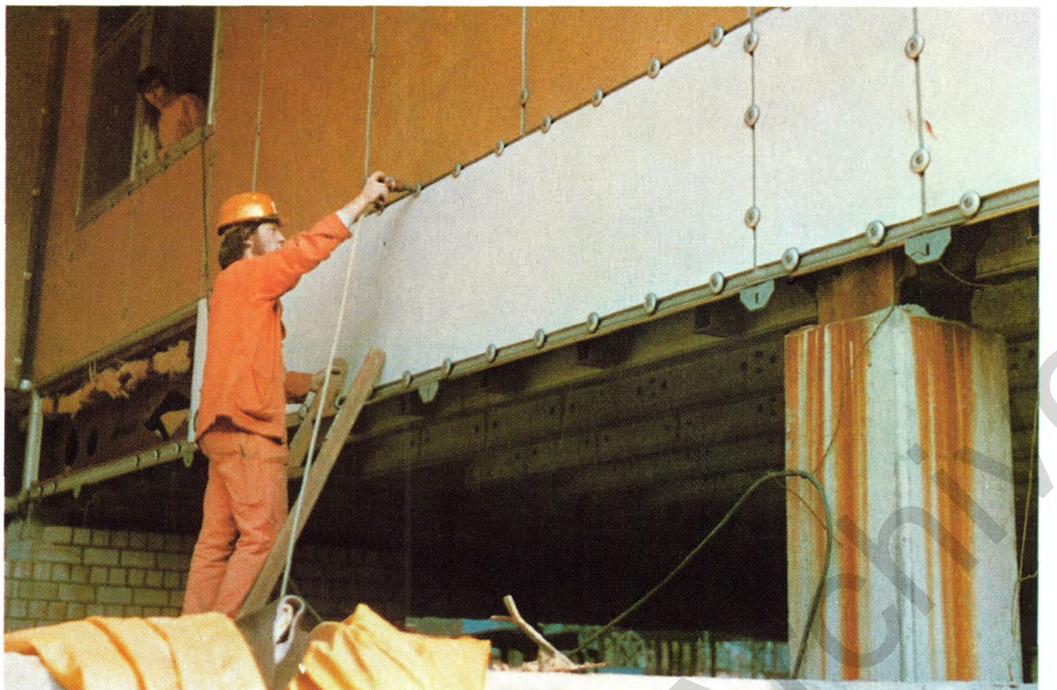
werden zusammengeschraubt. Rechts: Fassadenplatten werden angebracht. Die vorgefertigten Teile kommen einbaufertig zur Baustelle
