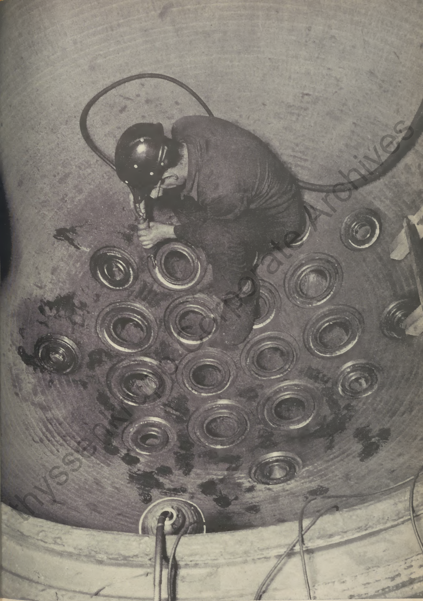
10. Einschweißen der Stutzen in den Deckel.
