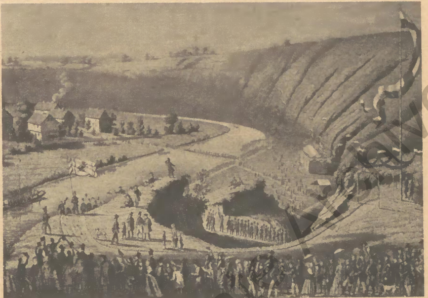
Erster Spatenstich an der Friedrich-Wilhelms-Nordbahn oberhalb Guxhagen am 1. Juli 1845. (Nach einer zeitgenössischen Steinzeichnung)
