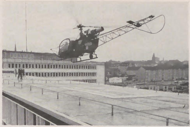
Der Dachflugplatz auf dem neuen Polizeiverwaltungsgebäude am Altmarkt wurde einer Belastungsprobe unterzogen. Dazu stellten die Henschel-Werke einen Alouette-Hubschrauber zur Verfügung. Flugkapitän Gerhard Gleuwitz landete und startete mit der Alouette mehrfach hintereinander zentimetergenau auf dem Dach. Ergebnis des Tests: der Bau ist solcher Belastung gewachsen und es ist möglich, daß die Polizei in besonderen Fällen von hier aus Hubschrauber einsetzen kann.
