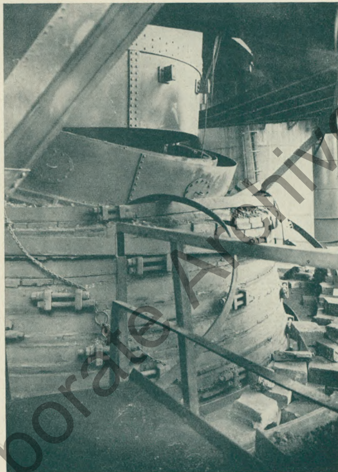
Oberer Schacht eines „zerknallten“ Hochfenz.
