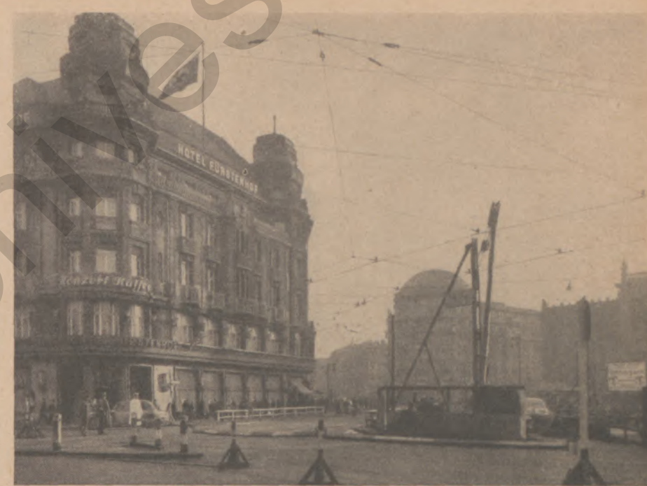
Abb. 9: Abladegerät der Dortmunder Union Brückenbau A.-G., mit dem die Konstruktionen in die Baugrube gelassen werden
