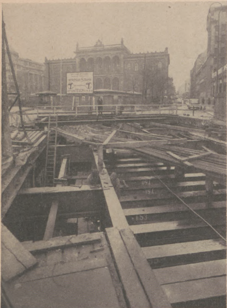
Abb. 12: Deckenträger und Unterzüge der südlichen Verkehrshalle von oben gesehen; im Hintergrund Potsdamer Fernbahnhof
