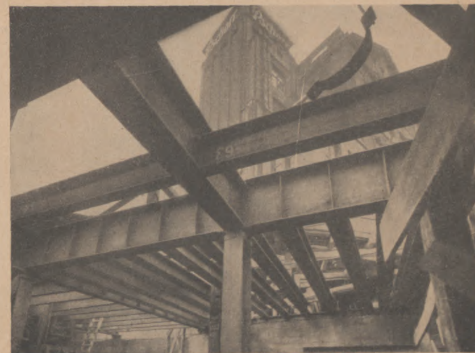
Abb. 11: Deckenträger und Unterzüge der südlichen Verkehrshalle
