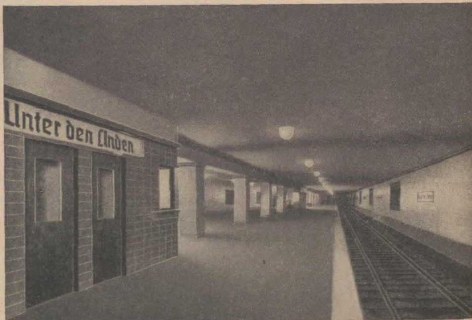
Abb. 16: Bahnhof Unter den Linden nach Beendigung des Innenausbaues
