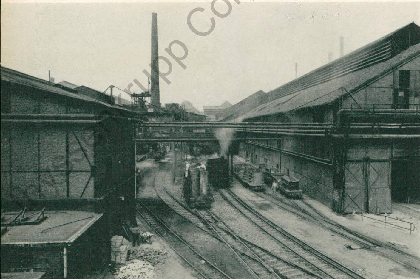
Normal- und Schmalspurgleisanlage zwischen Martinwerk I und Blockwalzwerk. Transportweg des Rohstahls auf Schmalspurwagen zu den Tiefföfen der Grobblechstraße und zum Blockwalzwerk.
