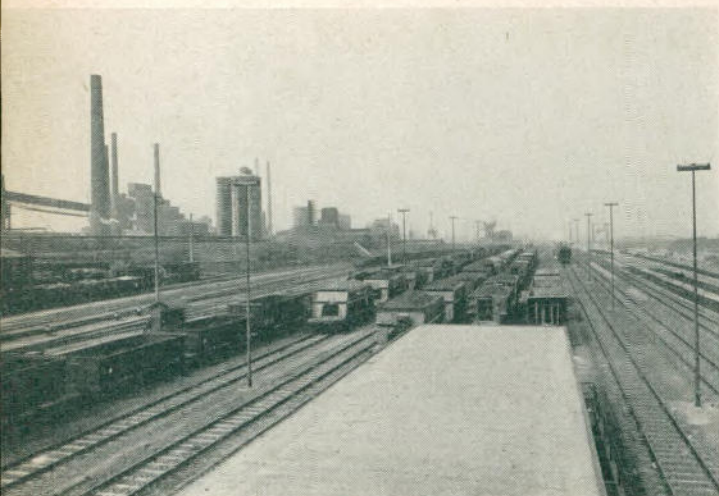
Ausblick von Stellwerk Ect auf die neue Gleisanlage des Hochofenbahnhofs. Im Hintergrund links die Kokerei.
