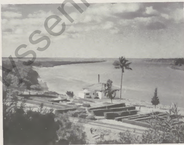
Abb. 4. Blick von Vila Luiza auf den Fluß Komati aufwärts. Am Flußufer entlang läuft die neue Bahnlinie Limpopo. (Wasserpumpstation)
