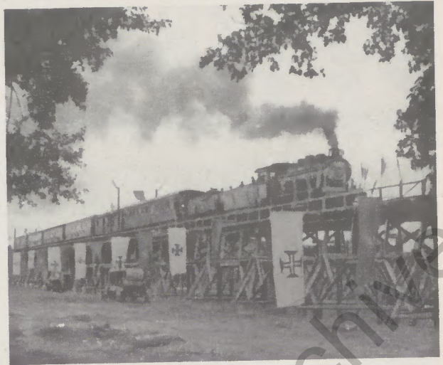
Abb. 3. Eröffnung der Limpopobrücke am 13. Februar 1954 Photo: CFM
